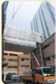
渡り廊下工事
