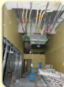
配線配管工事
