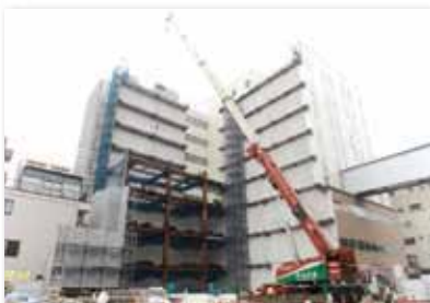
鉄骨建て方①
