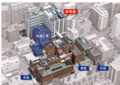
現工事エリア
