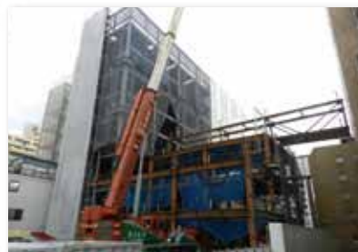
鉄骨建て方②(渡り廊下)
